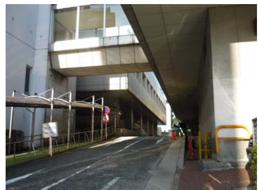
右側の建物が今年取り壊される予定の北館（旧健康管理センター）です
