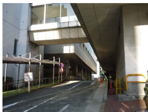
〈正面玄関へ続くスロープ〉
